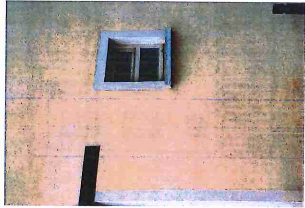
zoom sur une enduit traditionnel avec effet d'encadrement
