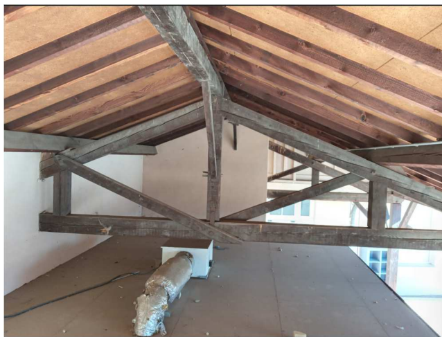
Figure 2 - Charpente bois préau
