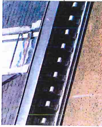
corniches bois à modillons formant dépassées de toiture
