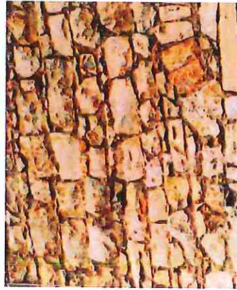
exemple de maçonnerie en « pierre dorée » destinée à être enduite...
