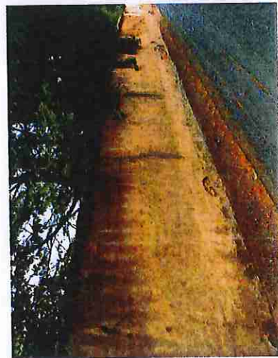
exemple de mur maçonné enduit et protégé par une couverture en tuiles creuses
